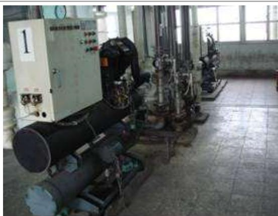
備註：具有相態變化(水蒸氣 <--> 水)之冷凝器及蒸發器
