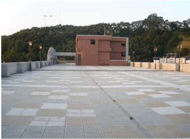
產學大樓雨水回收
